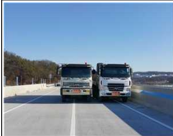
정적 재하시험 전경
