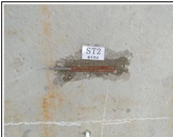
변형률계 설치 현황
