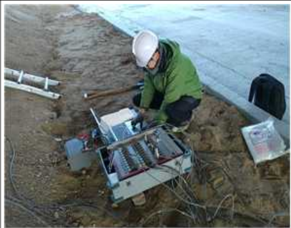
재하시험 계측 전경
